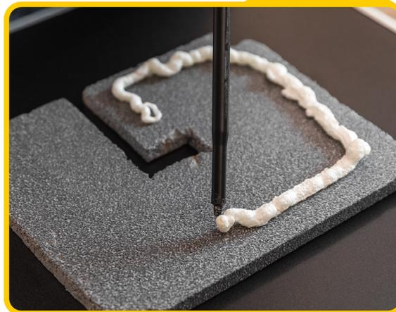
Bringe 2K-PU Schaum auf einer Seite der Dämmplatte auf.
