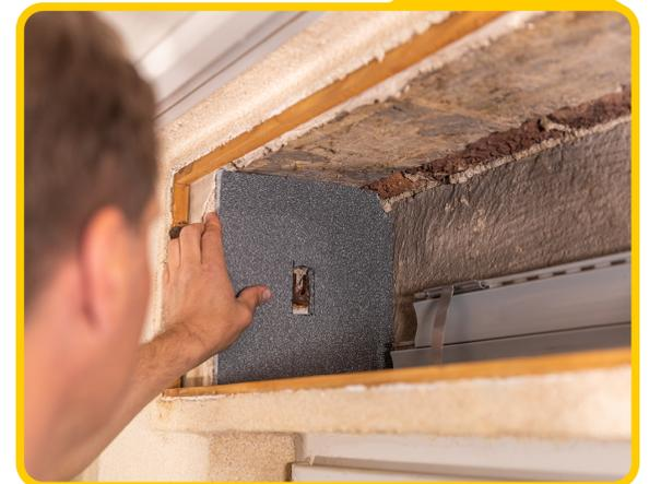
Fixiere die Seitenteile jeweils links und rechts an der Innenseite deines Rollladenkastens.
