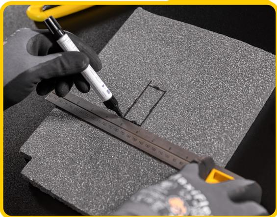
Übertrage die ermittelten Maße auf die Dämmplatten und schneide diese entsprechend zu.
