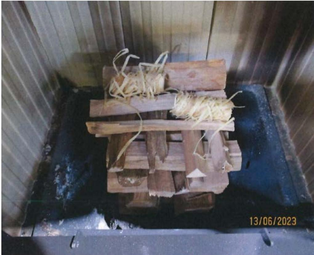
Die Anzündhilfe mit Hilfe eines langen Zündholzes oder einem Stabfeuerzeug entzünden. Das Anzünden von oben minimiert die Rauchbildung in der Anzündphase und unterstützt somit eine möglichst schadstoffarme Verbrennung. Sobald der Brennstoff Feuer gefangen hat die Primäreluftzufuhr reduzieren, sodass sie bei voller Flamme geschlossen ist.
