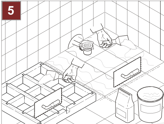
5. Auf beide Oberflächen (Untergrund und Unterseite des Trägers) wird Kleber (Flex-Fliesenkleber) mit Zahnpachtel aufgetragen.
