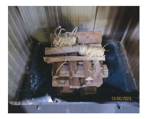
Die Anzündhilfe mit Hilfe eines langen Zündholzes oder einem Stabfeuerzeug entzünden. Das Anzünden von oben minimiert die Rauchbildung in der und unterstützt somit eine möglichst schadstoffarme Anzündphase Sobald der Brennstoff Feuer Verbrennung. gefangen hat die Primäreluftzufuhr reduzieren, sodass sie bei voller Flamme geschlossen ist.
