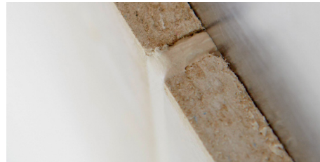
Komplett ausgefüllte Spachtelfuge (von oben) mit planebenem Ergebnis.
