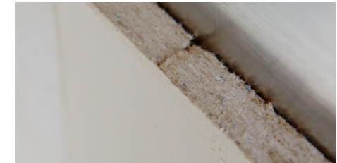
Der Fugenspalt beträgt weniger als 1 mm. Der Kleber muss die gesamte Fuge ausfüllen.
