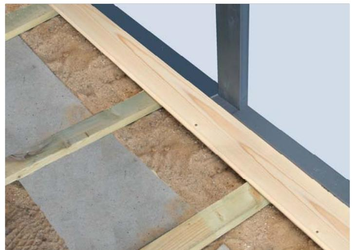
Befestigen Sie nun die Fußbodendielen mit je 2x B115-040 an den Grundlagern. Lassen Sie bei den Dielenbrettern rundherum einen Abstand von 0,5cm zu den seitlichen und der hinteren Schwelle, da sich das Holz ausdehnen könnte. Dann verbauen Sie alle weiteren Bretter mit dem Nut- und Federsystem.
