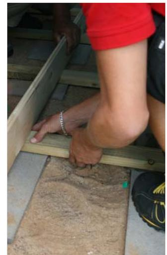
Verteilen Sie die Grundlager H28/70-03 in gleichmässigem Abstand. (Anzahl siehe Tabelle). Legen Sie die Grundlager, bündig an der vorderen Schwelle beginnend, parallel zur Frontseite. Verschrauben Sie die Grundlager mit dem Fundament. (Befestigungsmaterial für die Grundlager am Fundament ist nicht im Lieferumfang enthalten!)
