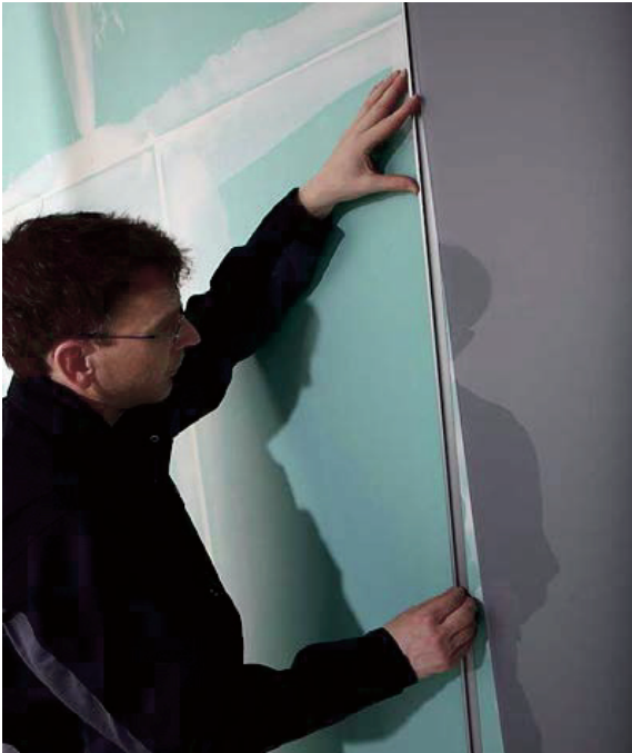
3.17 Das Abschlussprofil (ebenfalls mit einer dünnen Linie auf der Flanke silikonieren) kann vor oder unmittelbar nach dem Anbringen der Platte aufgesetzt werden.
